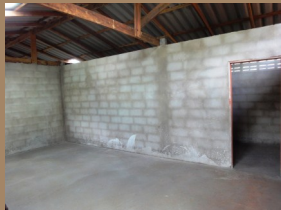
Wände u. der Boden sind fertig
