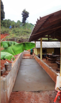
Die neue Mauer
